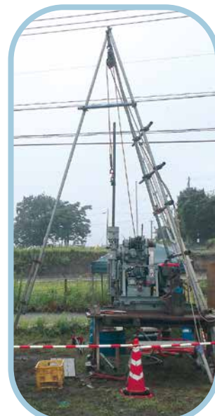
ボーリング調査をしているようす
