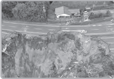
地震によってくずれ落ちた道路
