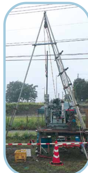
ボーリング調査をしているようす
