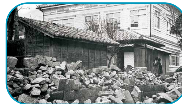
桜島地震でこわれた鹿児島市内の石垣
