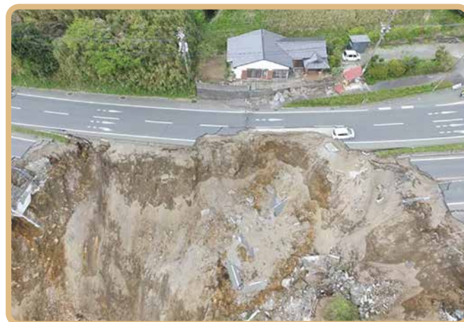
地震によってくずれ落ちた道路
