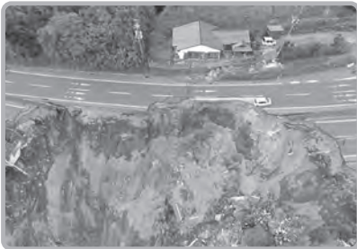
地震によってくずれ落ちた道路
