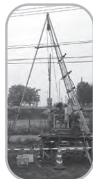
ボーリング調査をしているようす
